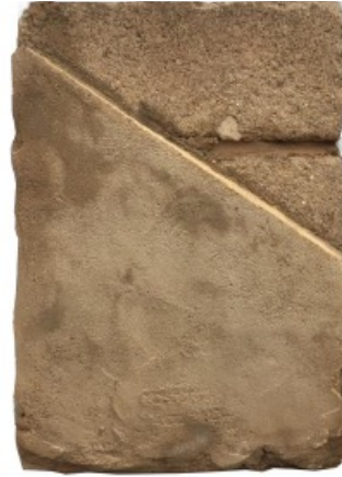
Mur en block ciment
